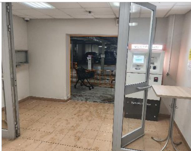
Фотография 5. Здание торгово-развлекательный центр. -1эт паркинг.
