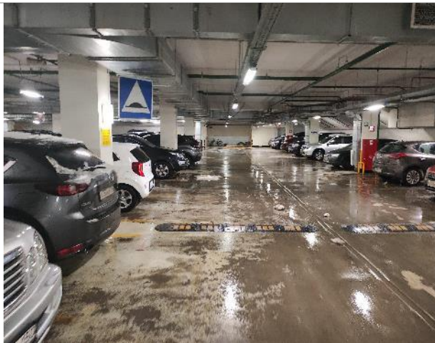
Фотография 14. Здание торгово-развлекательный центр. -1эт паркинг.
