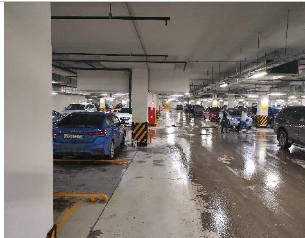
Фотография 13. Здание торгово-развлекательный центр. -1эт паркинг.
