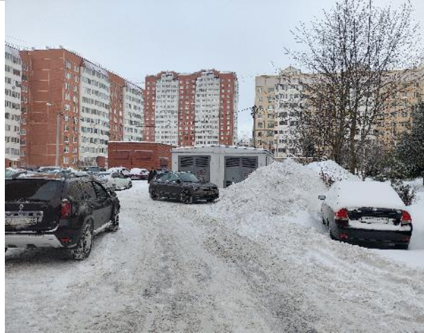
Фотография 134. Трансформаторная подстанция.
