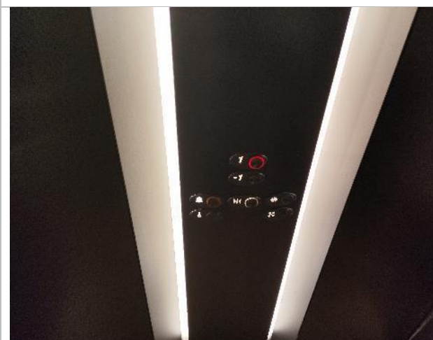
Фотография 23. Здание торгово-развлекательный центр. -1эт паркинг.
