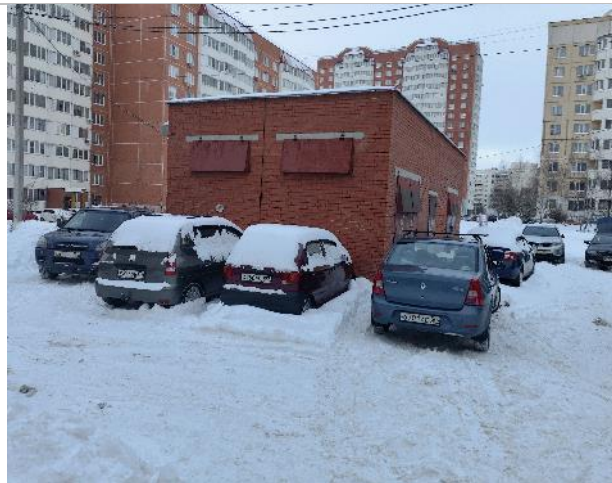
Фотография 136. Трансформаторная подстанция.
